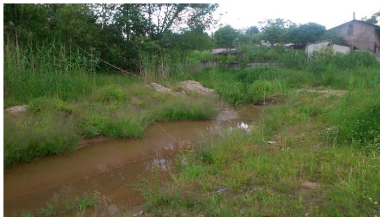
Сброс дренажных вод с территории частного сектора. Участок р. Волхов – г. Новая Ладога
