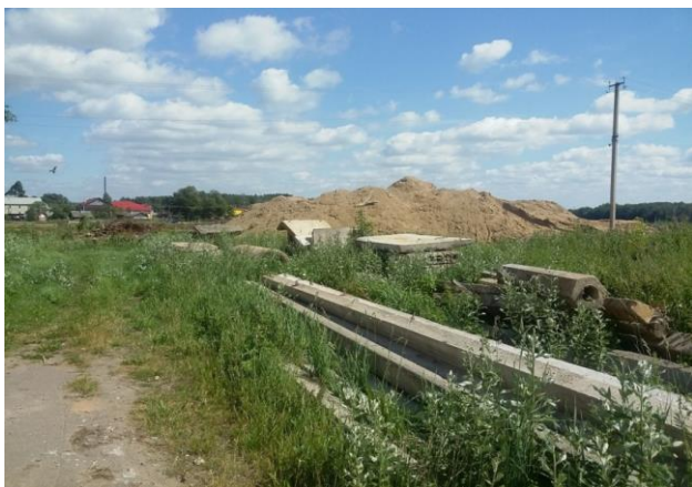
Размещение отвалов размываемых грунтов в пределах прибрежной защитной полосы. Участок р. Оять – д. Доможирово
